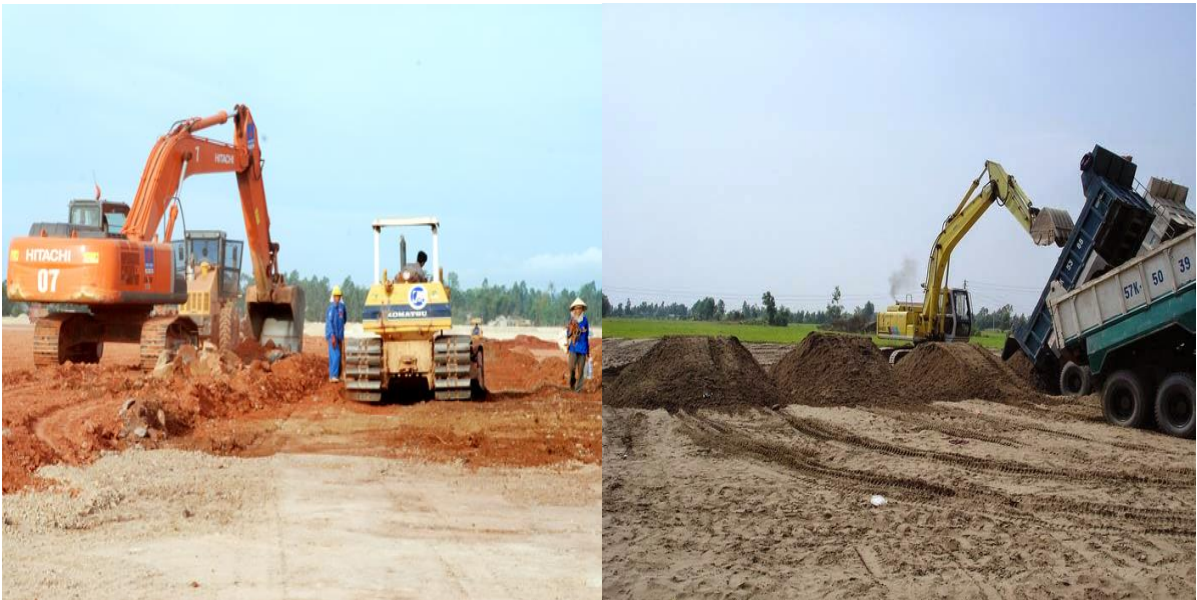
Thi công và san lấp mặt bằng
